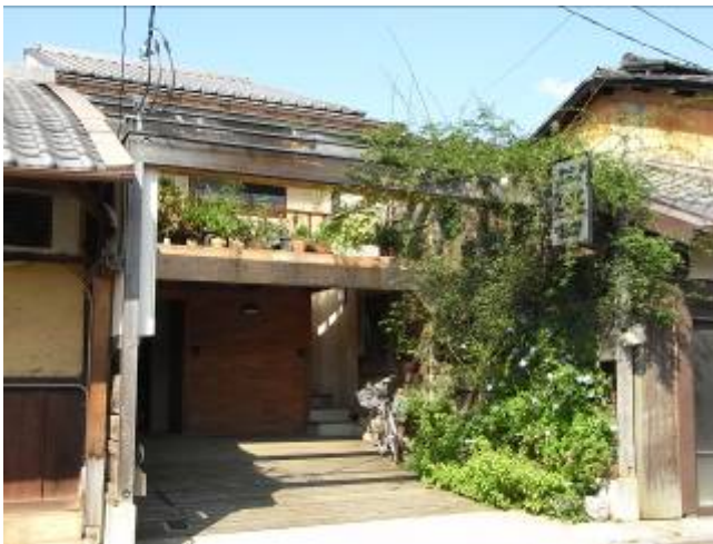
【建物玄関前の様子】
