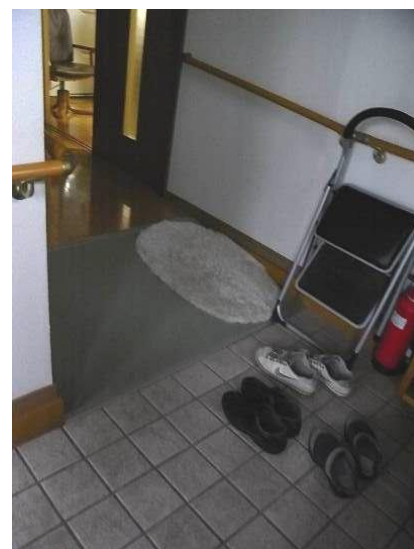
【玄関スロープ】
