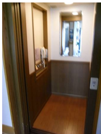
【ホームエレベーター】
