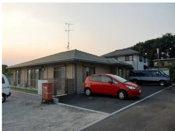
【敷地東側からの全景】
