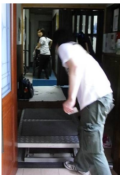
【玄関の昇降機】
