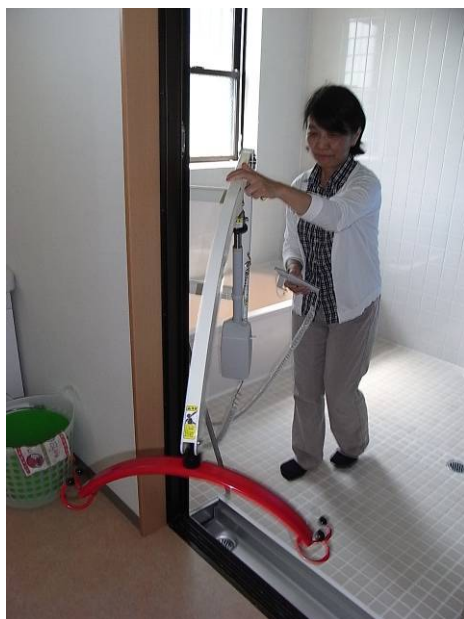
【リフト付き浴室】
