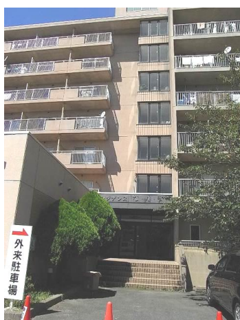
【職員寮の全景】
